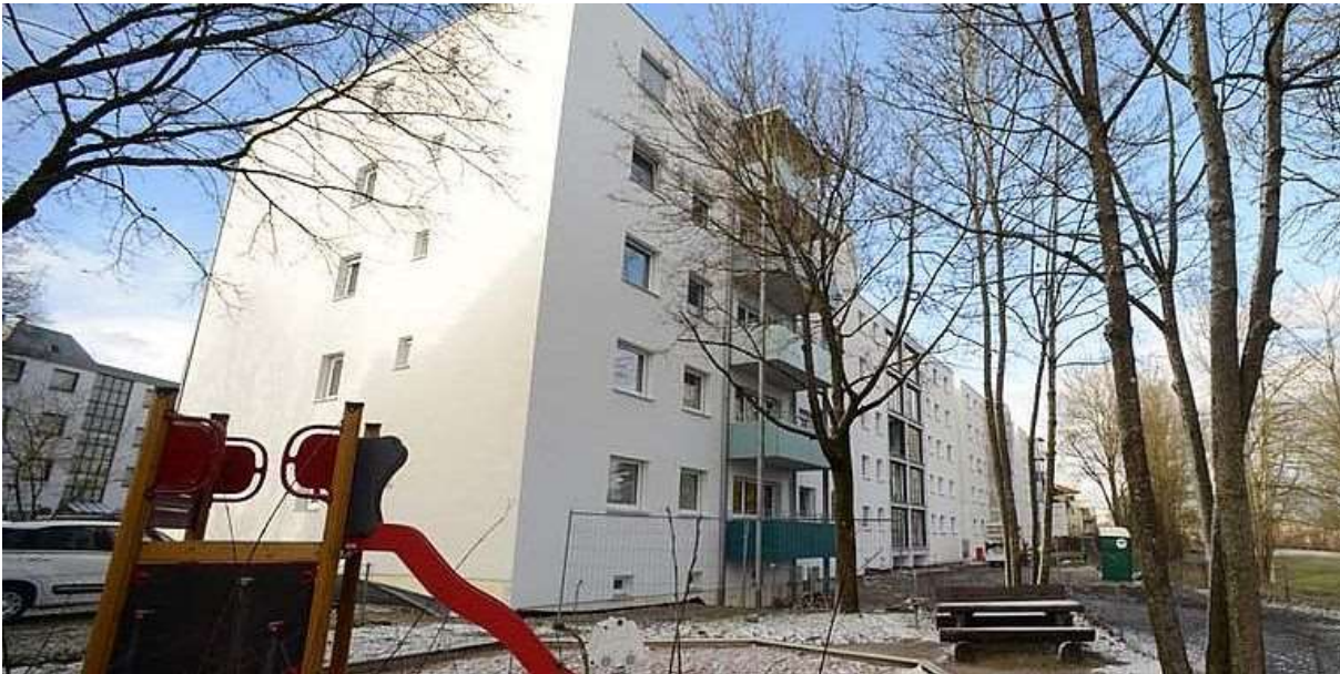
In diese Wohnanlage der Wohnbaugruppe Augsburg (WBG) mit 70 Wohnungen bauen die Stadtwerke Augsburg eine Power-to-Gas-Anlage ein. - Bild: ©SWA / Hosemann
