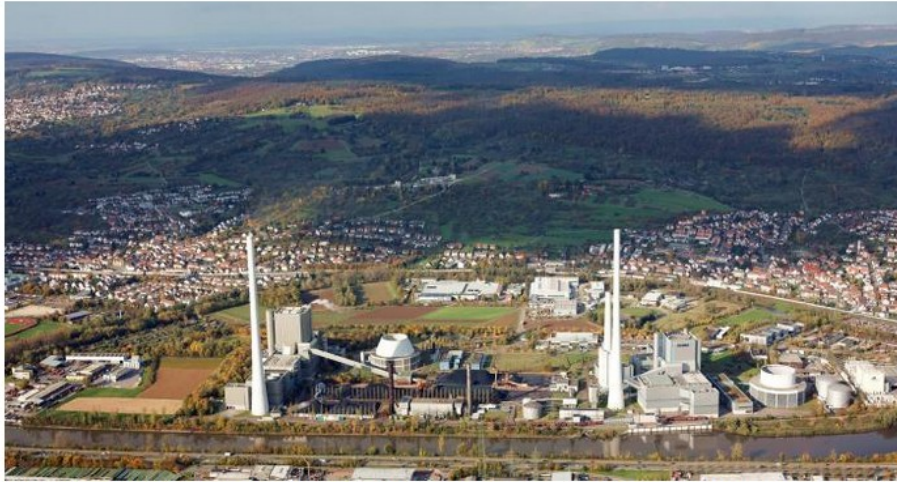
Block 1 des EnBW-Heizkraftwerks Deizisau/Altbach steht für den kommerziellen Betrieb nicht mehr zur Verfügung. (Foto: EnBWAG)
