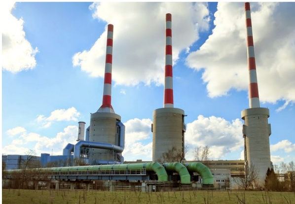
Das Tauziehen um die Zukunft des Gaskraftwerkes Irsching geht in eine neue Runde: Erneut haben die Eigner jetzt die Stilllegung der Anlage wegen mangelnder Wirtschaftlichkeit beantragt (Foto: Art Anderson/Wikimedia )
