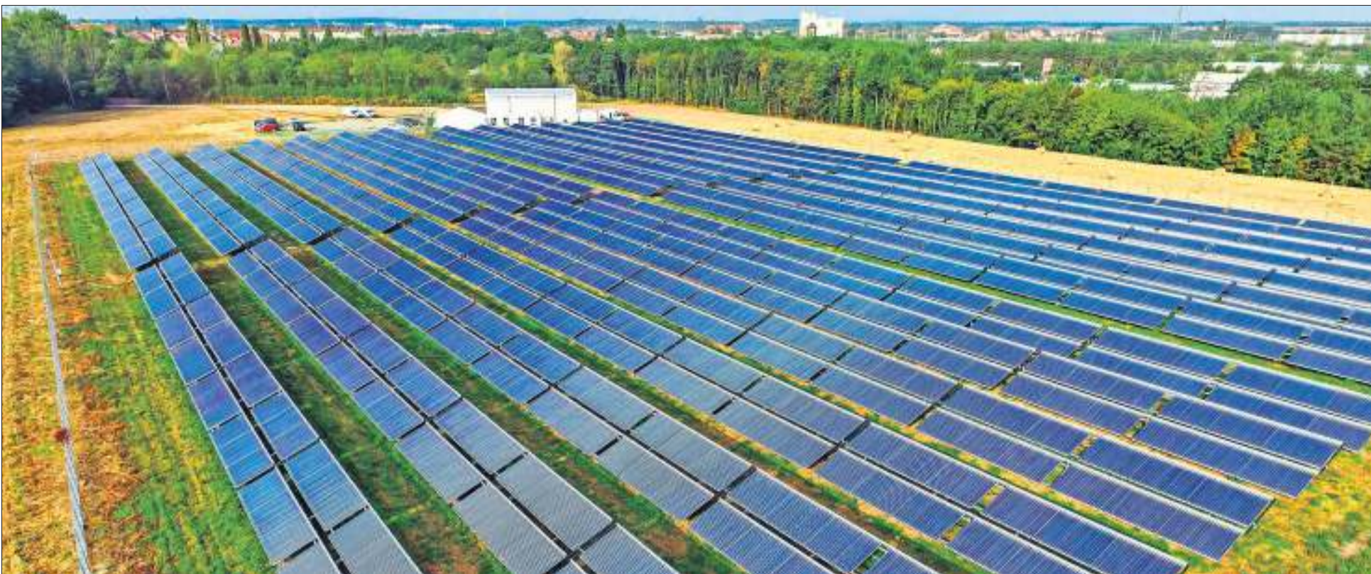
Der bisherige Rekordhalter: Die Solarthermieanlage in Senftenberg hat eine Kollektorfläche von 8300 Quadratmetern.
