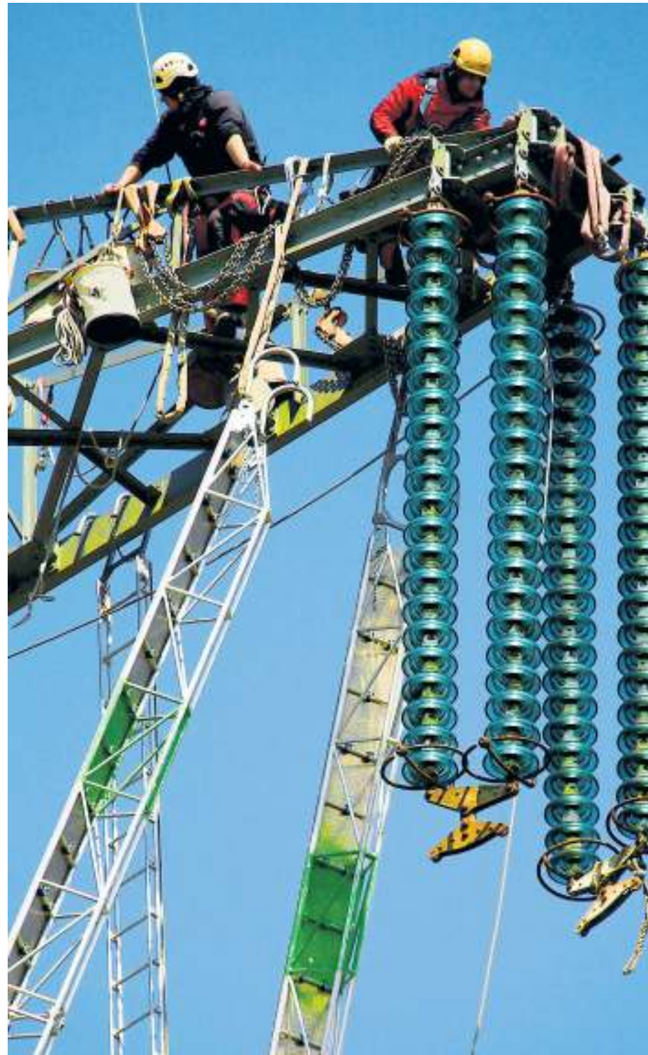
Das Stuttgarter Stromnetz soll mehr als 100 Millionen Euro Wert sein.
