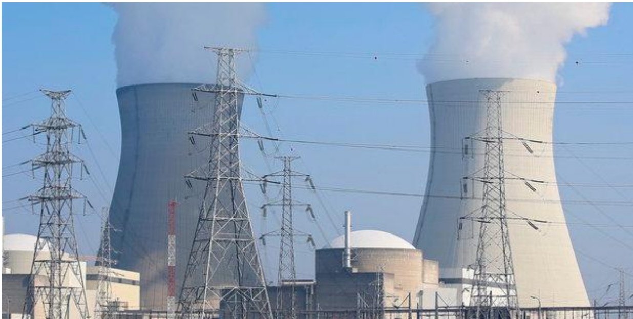
Alt, störanfällig und mit langen Ausfallzeiten: die belgische Anlage in Doel
